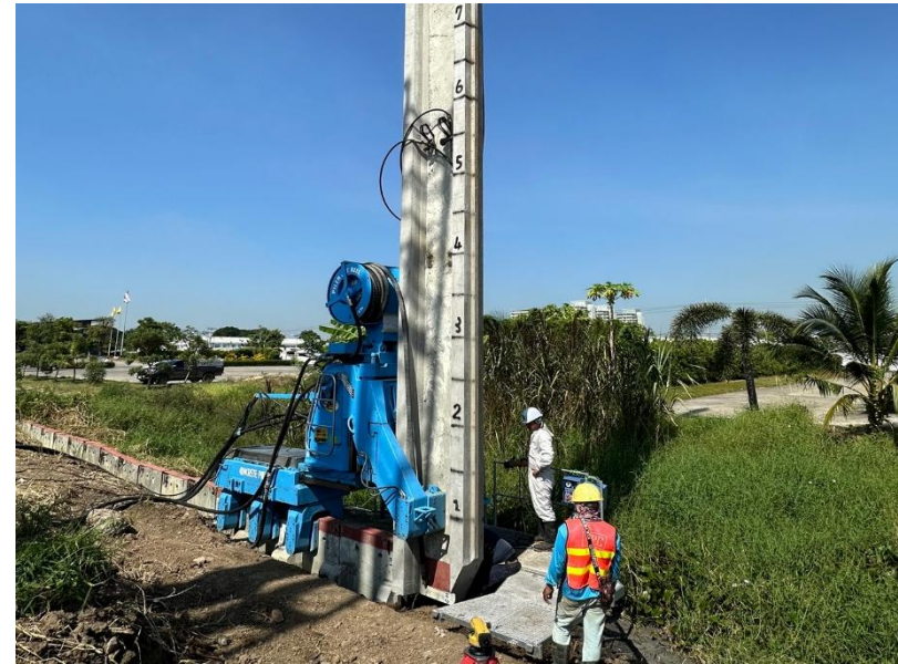
コンクリート矢板試験施工の様子
