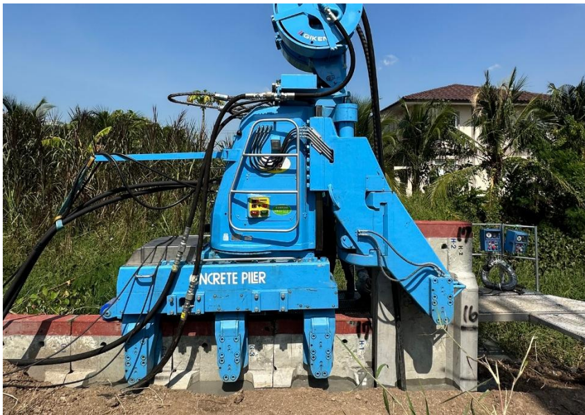
コンクリート矢板試験施工の様子
