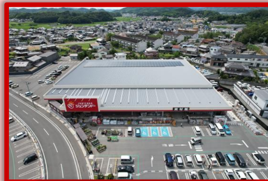
太陽光発電設備設置後の加西店(兵庫)の様子
