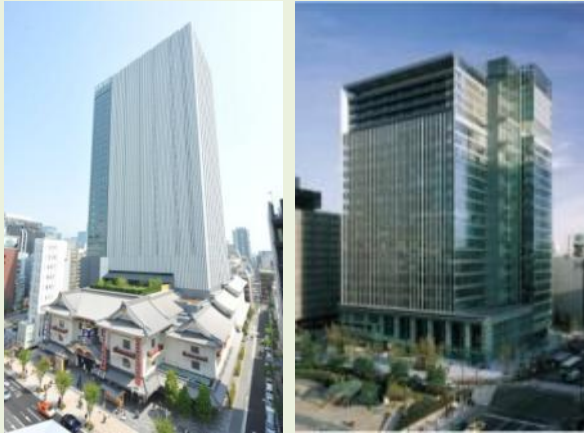
歌舞伎座タワー・銀座松竹スクエア 銀座2丁目松竹ビル・銀座2丁目松竹ビルANNEX 東劇ビル・松竹倶楽部ビル
