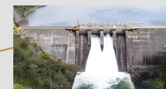
幌満川水力発電所
