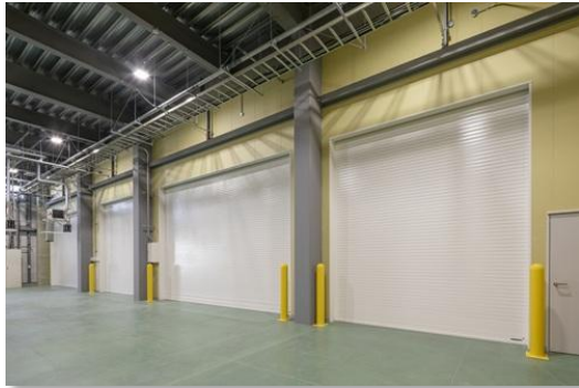
物流倉庫に設置される 「重量シャッター」
