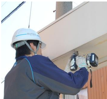
シャッターの修理作業
