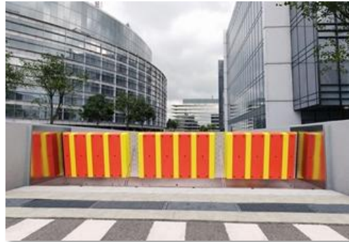
浮力起伏式止水板 「アクアフロート」
