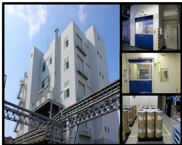
泉工場製造棟（大阪府泉大津市）
