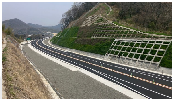
令和7年度笠岡バイパス横島地区舗装工事
