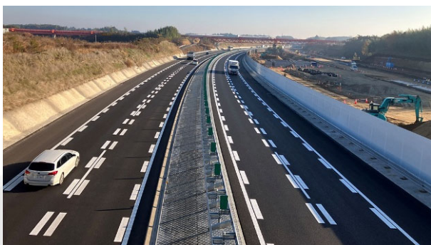
東関東自動車道成田地区舗装工事
