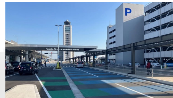
福岡空港国際線カーブサイド整備工事
