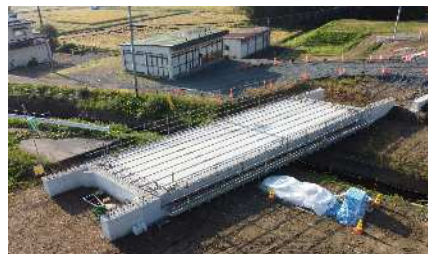
橋げた設置完了状況
