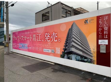
大型広告シート
