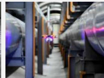
地下洞道点検
