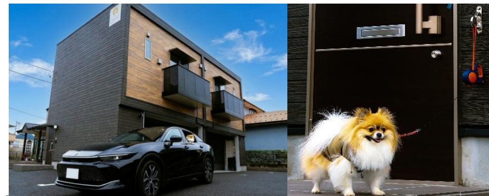
静岡県御殿場市（ペット共生型ガレージハウス）
