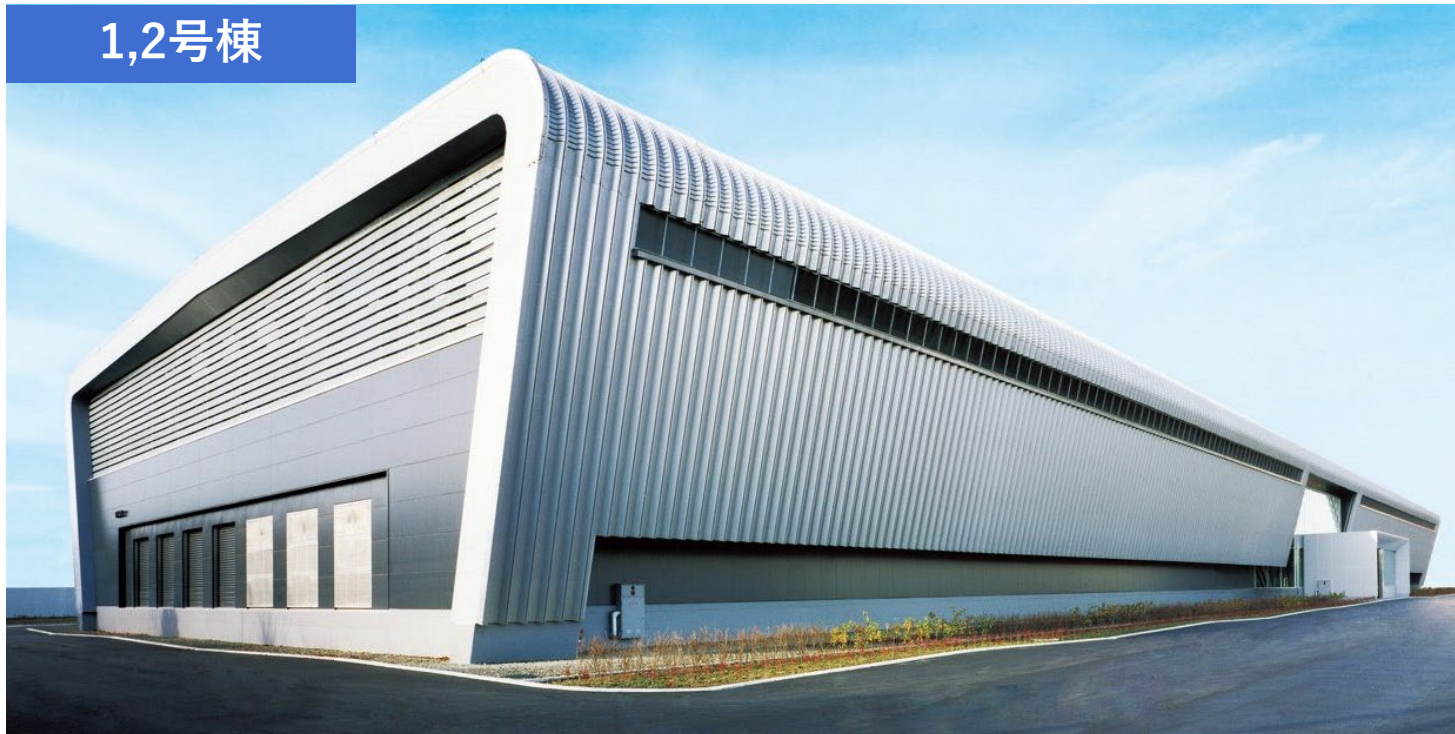
1,2号棟：直接外気冷房方式
