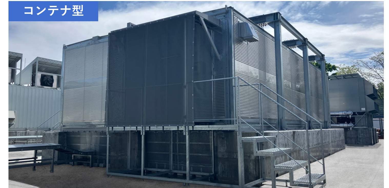
コンテナ型：高効率液冷方式
